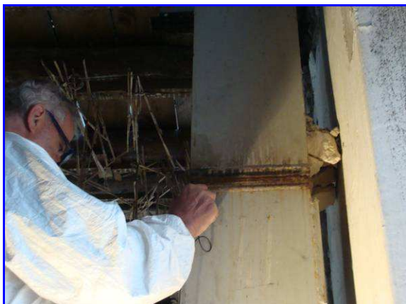
Controllo con ultrasuoni
