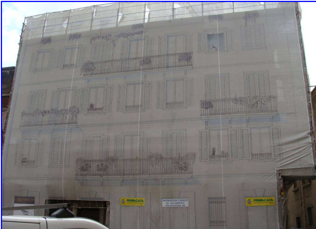
Ristrutturazione edificio in centro storico
