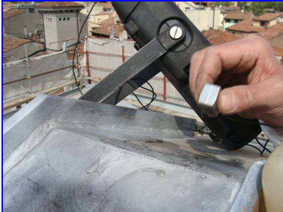
Giunzione tra le 2 travi del colmo
