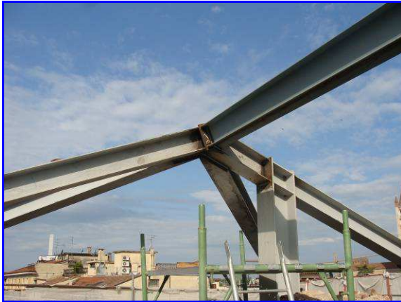
Parte della struttura in copertura
