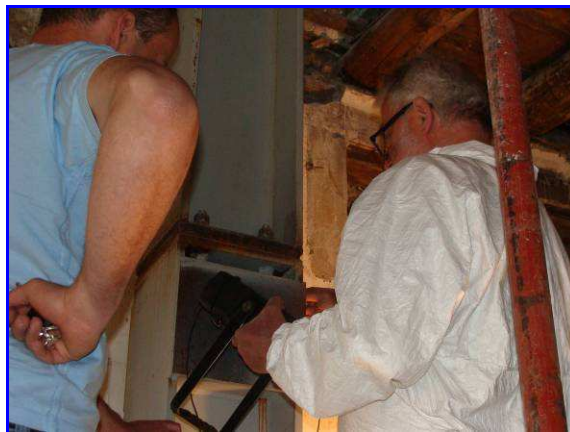
Controllo sul giunto trave - piastra
