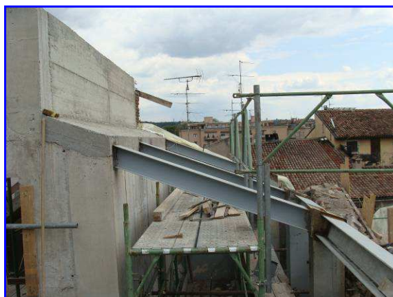
Travi con errata preparazione dei lembi
