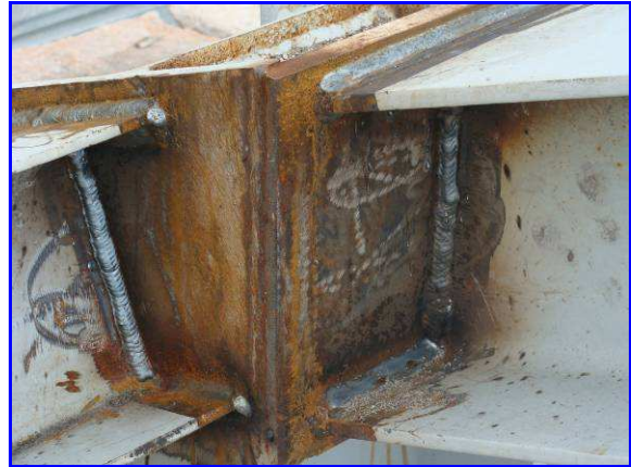
Particolare di un nodo in copertura
