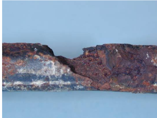
Figura 2. Attacco localizzato per pitting su una barra d'armatura rimossa da un calcestruzzo contaminato con cloruri.
