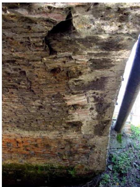
Ponte di Campazzino - Milano
