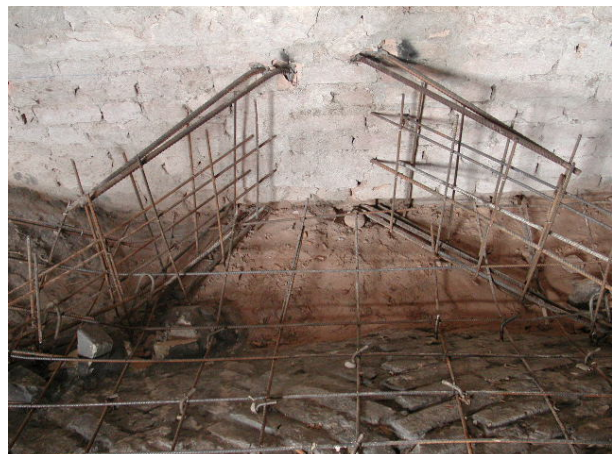
Figura 1/a. Consolidamento con cappa in cemento armato. Pianta e schema assonometrico (Rocchi, Piccirilli-1991)
