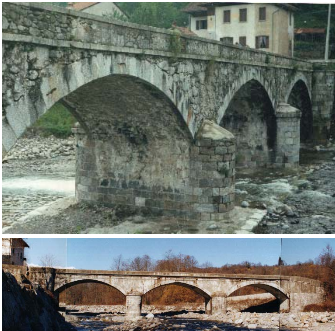
Figura 24. Viste del ponte
