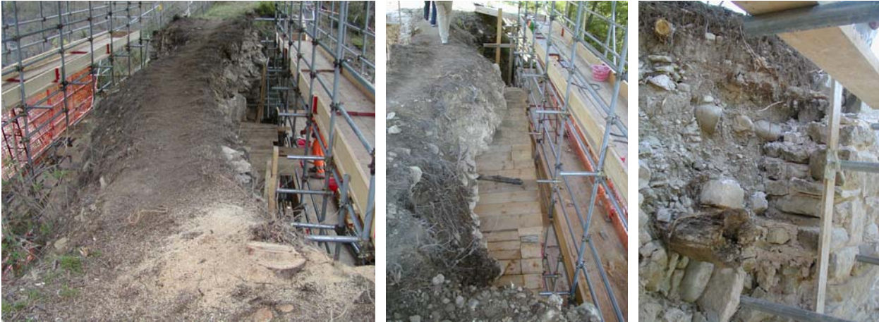
Figura 36. Immagini di cantiere: situazione precedente agli interventi di ricostruzione delle porzioni crollate di volta e di muri di testa.
