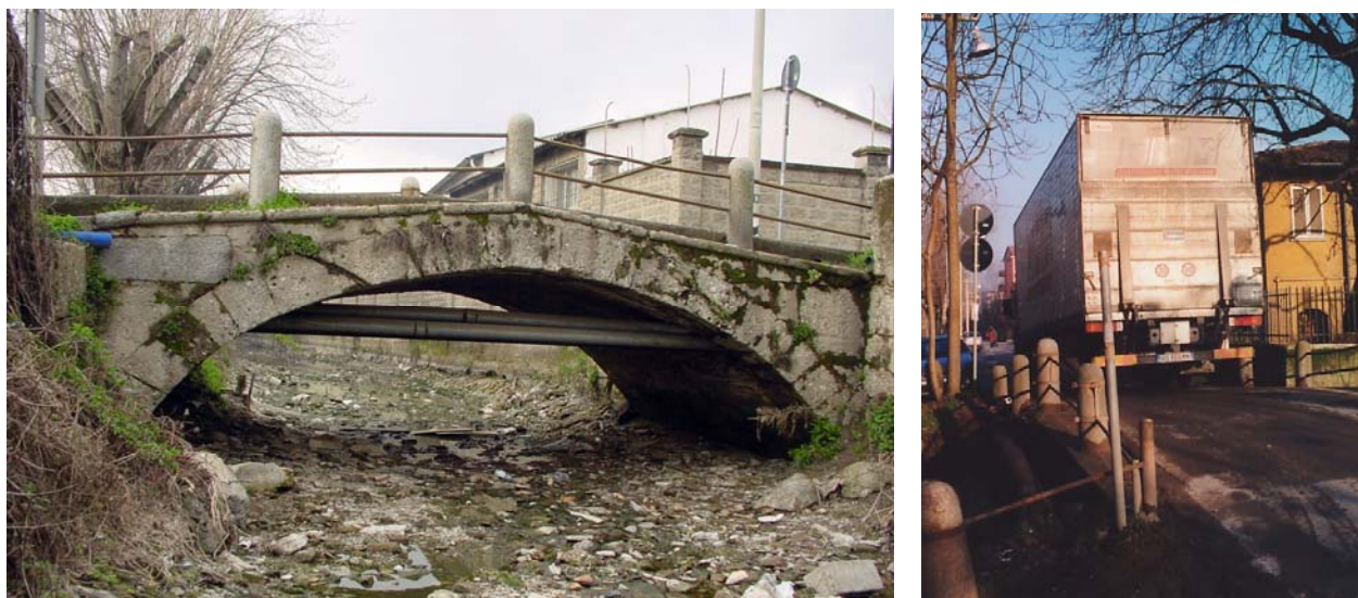
Figura 39. Immagini di insieme del ponte
