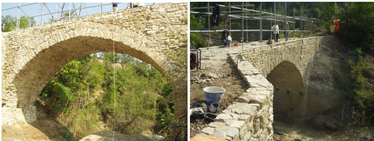
Figura 38. Immagini di cantiere: Fasi di ultimazione dei lavori.
