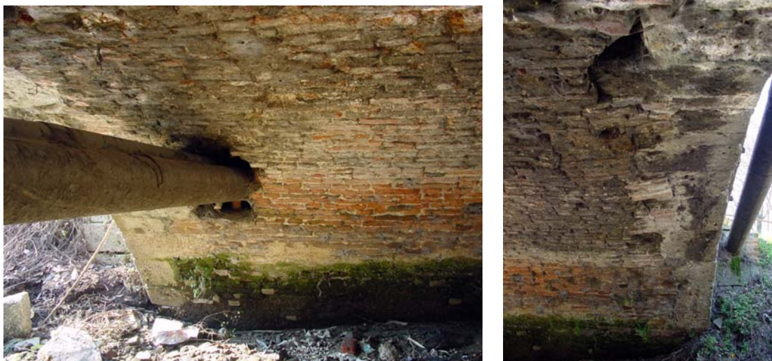
Figura 40. Immagini di dettaglio della volta muraria portante
