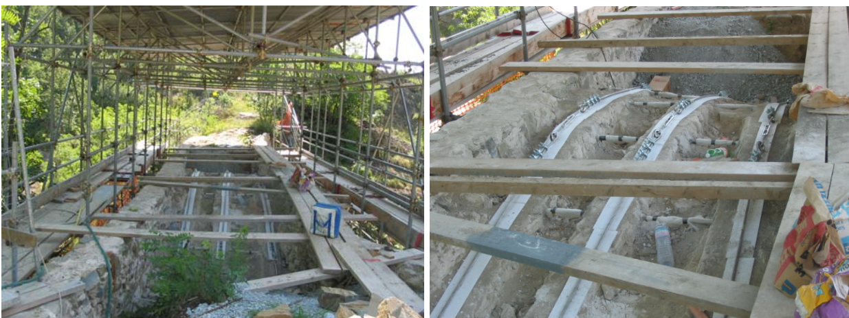
Figura 37. Immagini di cantiere: Fasi di posa degli archi armati di estradosso.
