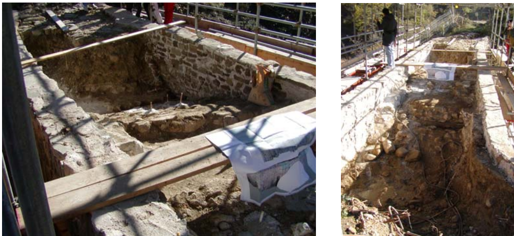
Figura 36. Immagini di cantiere: situazione riscontrata al termine della fase di rimozione dei rinfianchi.
