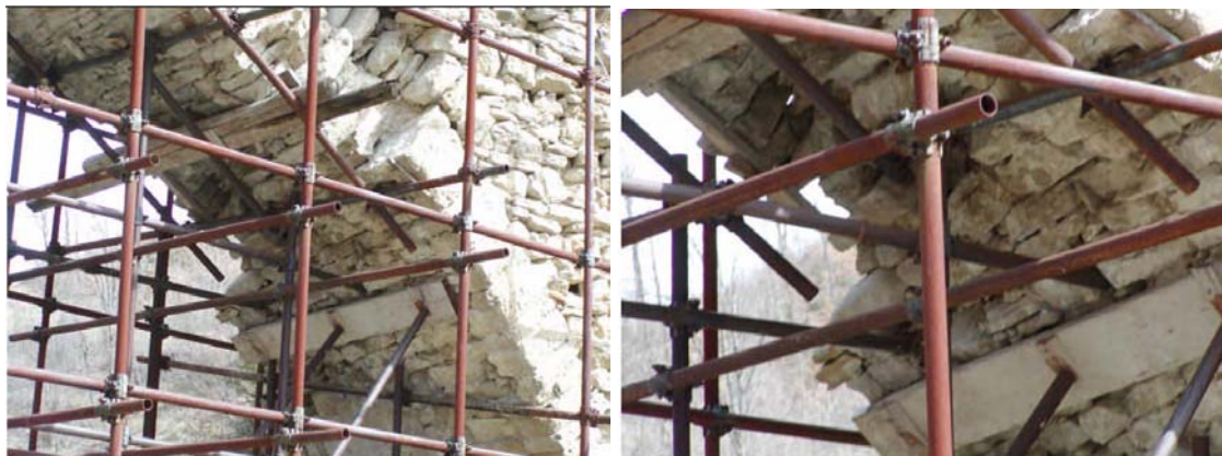
Figura 34. Situazione precedente l'intervento di presidio.
