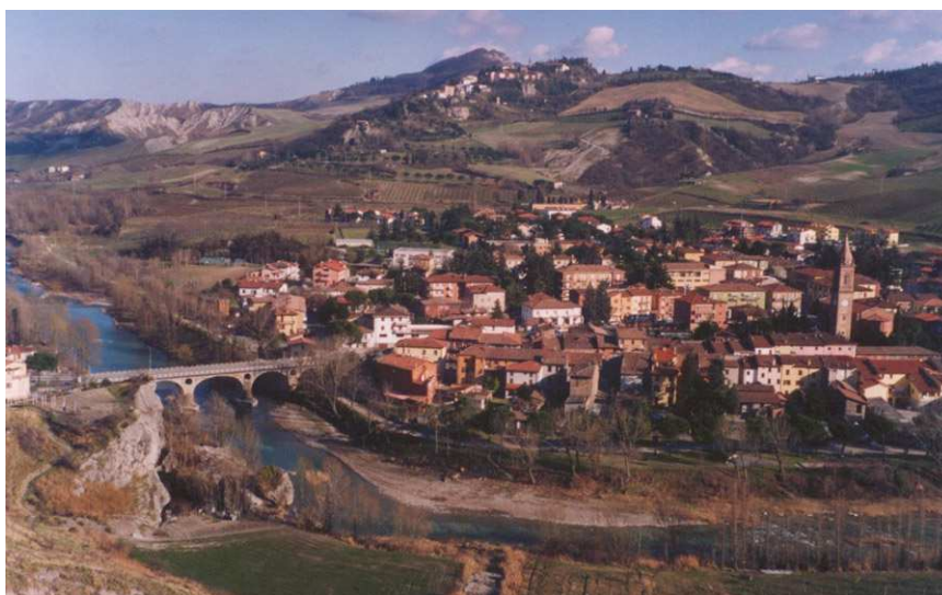
Figura 4: Il ponte storico come accesso a Borgo Tossignano
