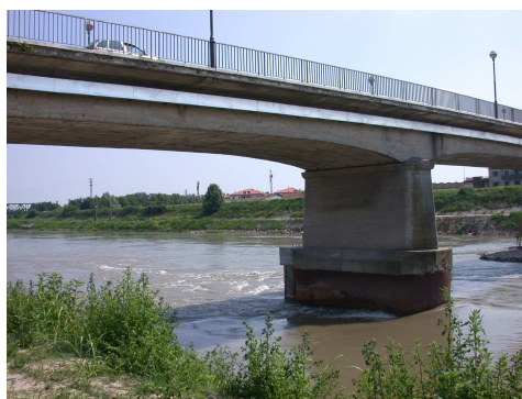
Figura 1: Stato del ponte prima dell'intervento
