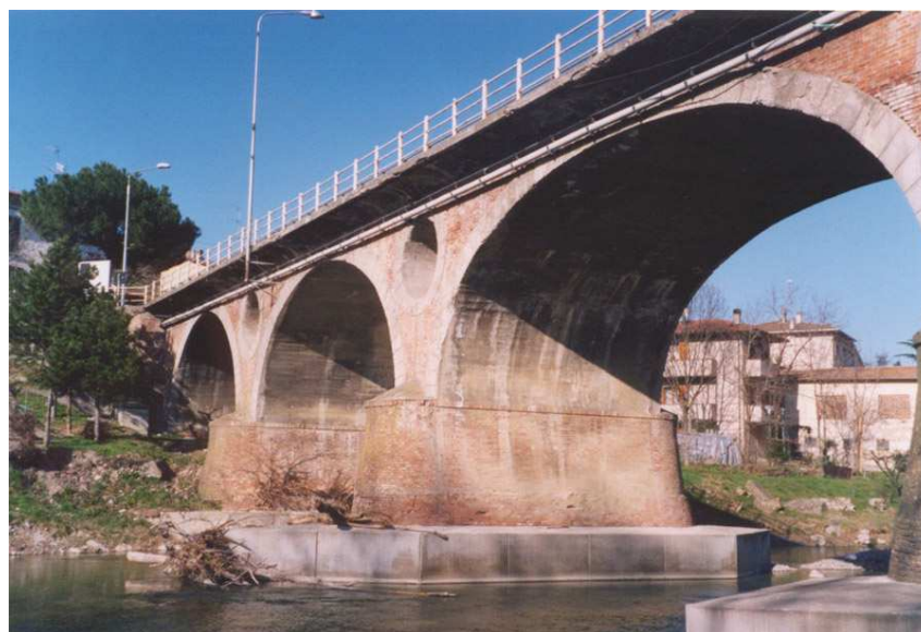
Figura 5: Il ponte storico
