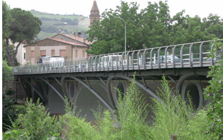
Figura 7: L’andamento degli archi in acciaio in corrispondenza degli archi in muratura
