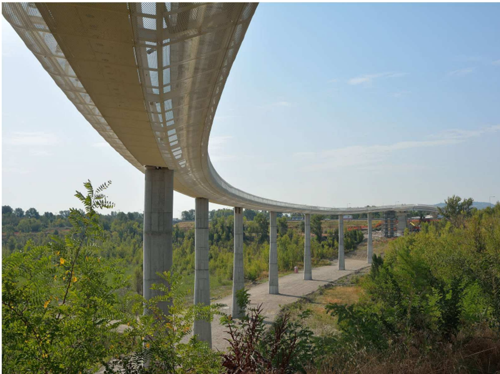
Figura 1. Particolare di un tratto del People Mover.
