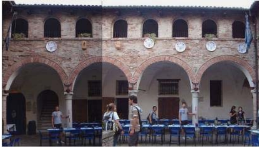
Fig. 16.a: Vista dei quattro porticati interni al chiostro, lato 1
