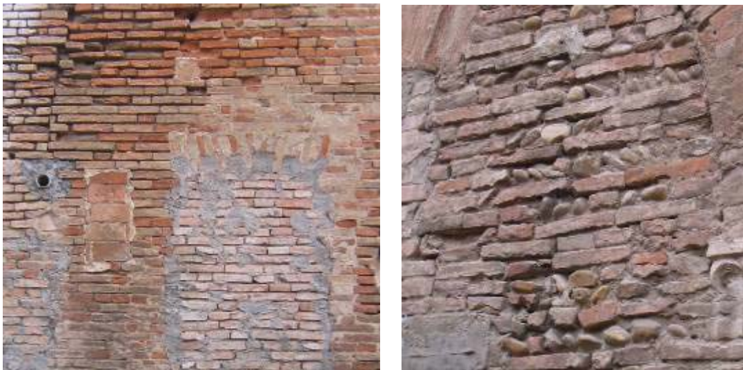
Fig. 8: Murature eterogenee del complesso S. Domenico a Cesena
