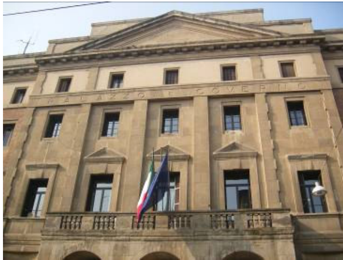
Foto 1.1.: Vista della facciata su Piazza Galilei della Questura di Bologna
