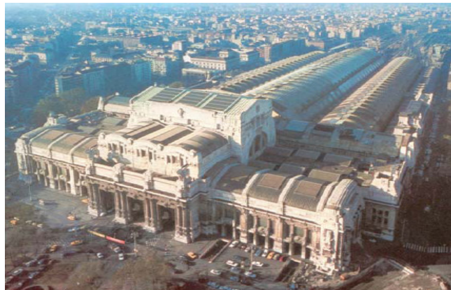
Figura 1.3.: Vista della Stazione Centrale di Milano dal Pirellone
