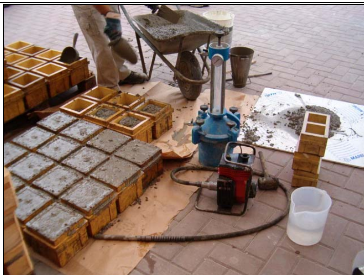
confezionamento cubi in sede di qualifica della miscela di calcestruzzo
