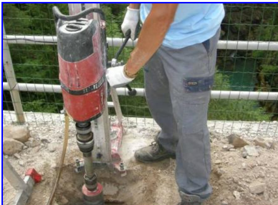
Esecuzione del carotaggio C1
