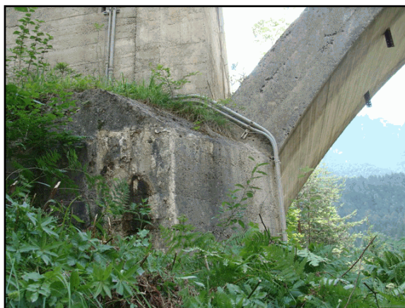
Foto 4: si osserva la crescita di vegetazione sulle spalle.
