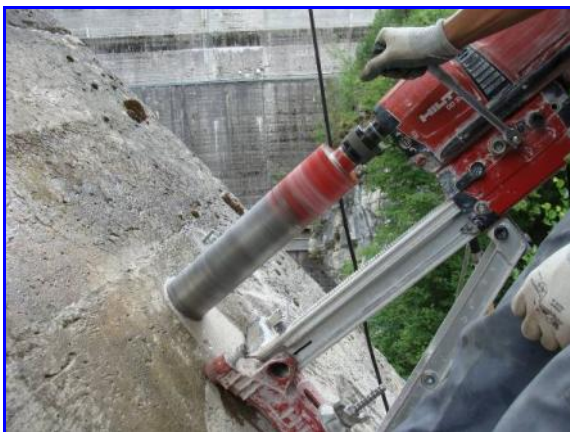
Esecuzione del carotaggio C2
