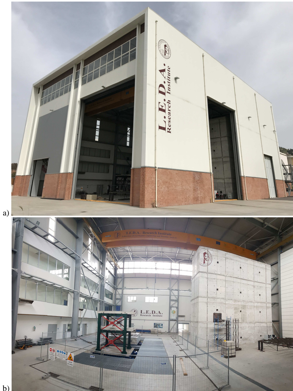
Figura 1. Centro di Ricerca L.E.D.A. a) Vista esterna; b) Vista interna.
