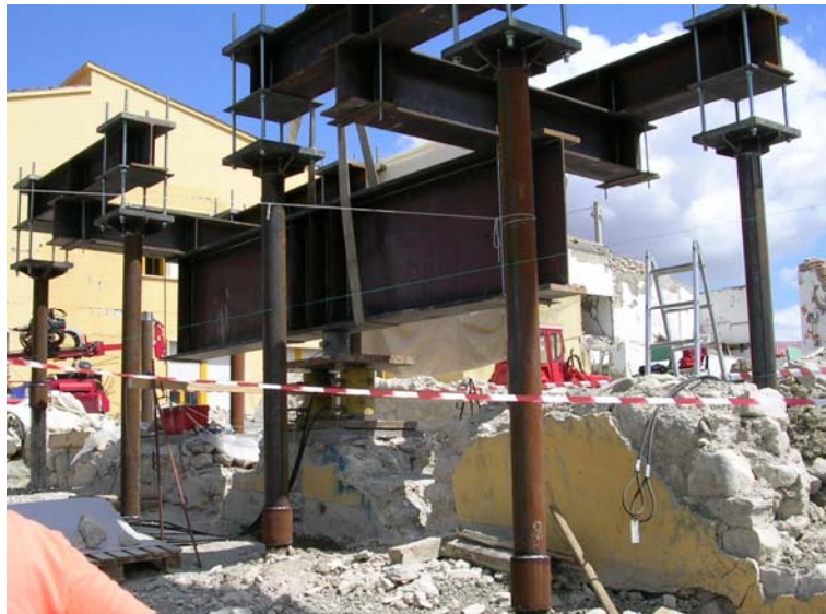
Figura 1. Attrezzatura di sperimentazione in sito
