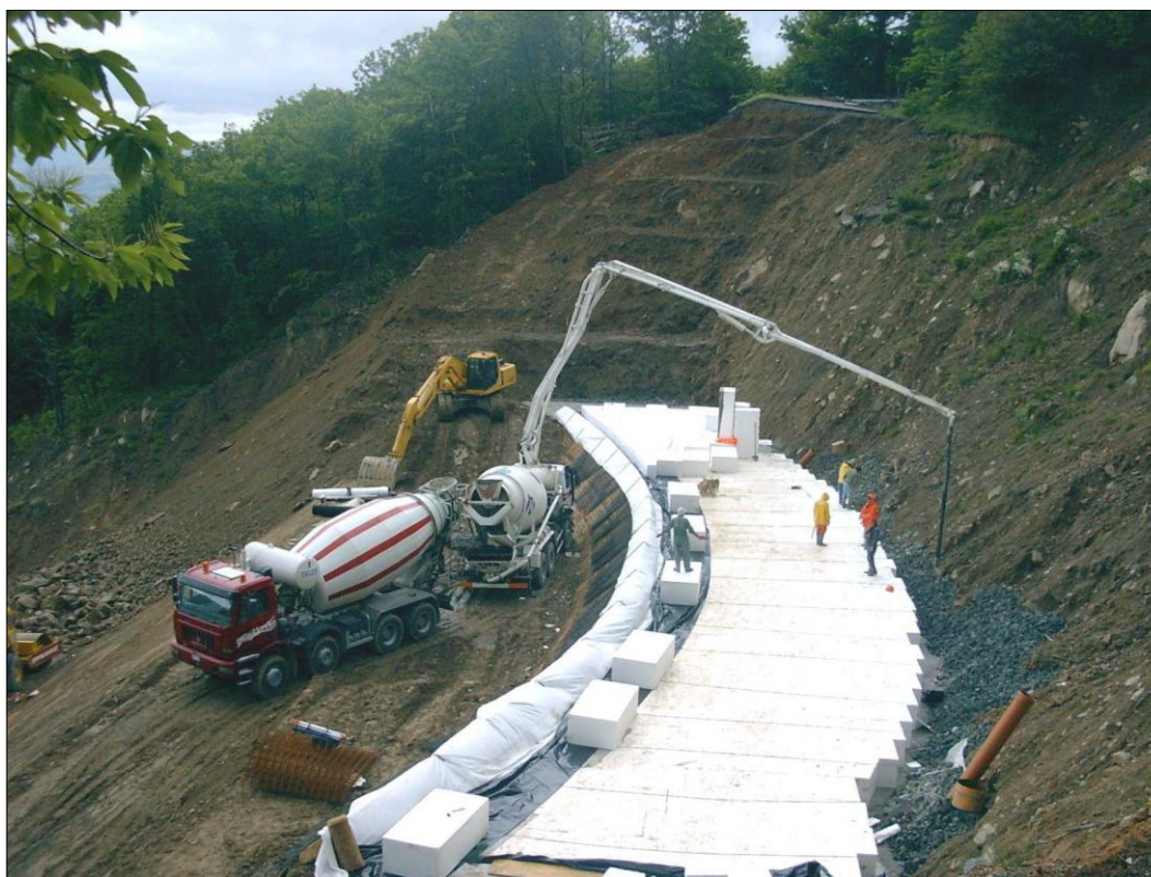
Foto 1. Lavori di posa del primo rilevato sperimentale in EPS in Italia (Provincia di Parma).
