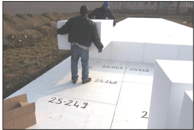
Figura 1. Schema di posa dei blocchi di EPS.
