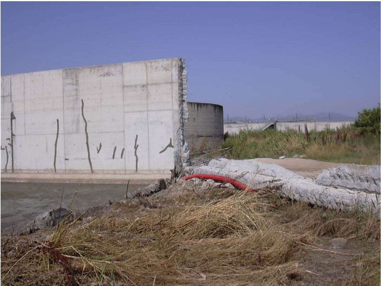
Illustrazione 1: Collasso di una vasca
