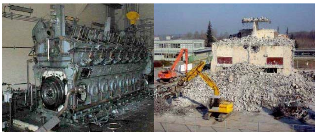
figura 3 – smantellamento di un componente e demolizione dell’edificio
