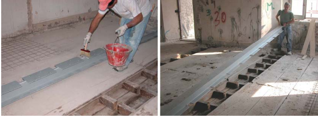
Figura 4, Fase di inserimento della trave GFRP nel solaio in legno (Borri, 2004)
