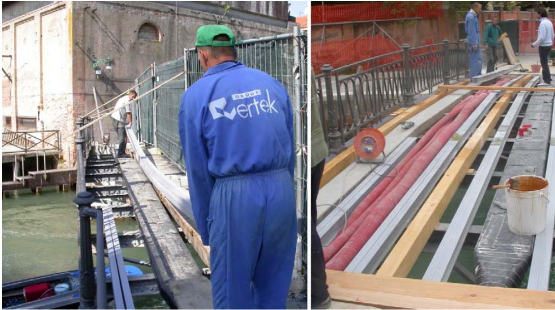
Figura 10, Fase di posizionamento delle travi GFRP
