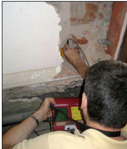
Figura 6: Strumentazione ed esecuzione delle prove con pacometro
