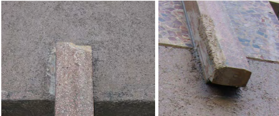
Figura 14: Distacco di spigoli vivi
