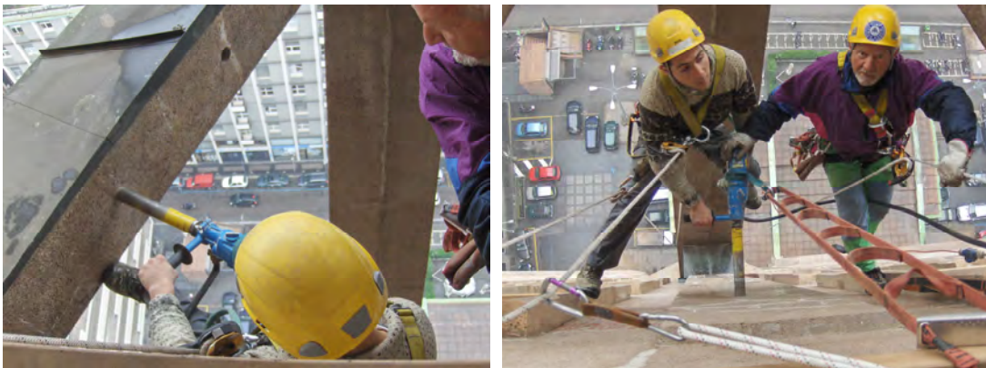
Figura 10: Estrazione di carote della seconda fase
