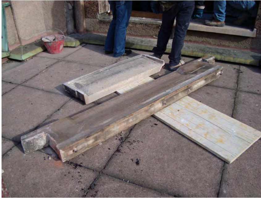
Figura 9: Pilastrino smontato per verifica sulle modalità di ancoraggio
