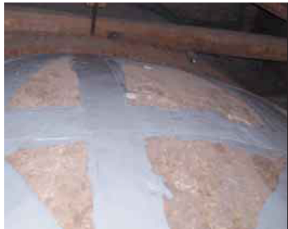
Figura 8: Intervento n°3: rinforzo delle volte e delle cupole mediante realizzazione di una rete di strisce di G-FRP secondo meridiani e paralleli.
