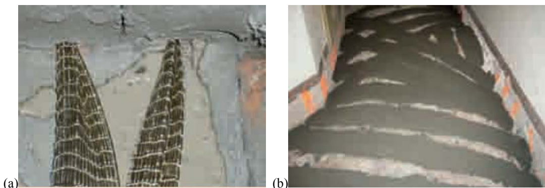
Figura 25: Posa di elementi di rinforzo SRCM (a) su volta in muratura, mediante reticoli di strisce (b).
