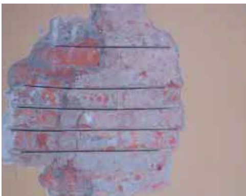
Figura 11: Intervento n°7: repointing dei giunti di malta con inserimento di armature a taglio costituite da barre Ø 4 mm in C-FRP.
