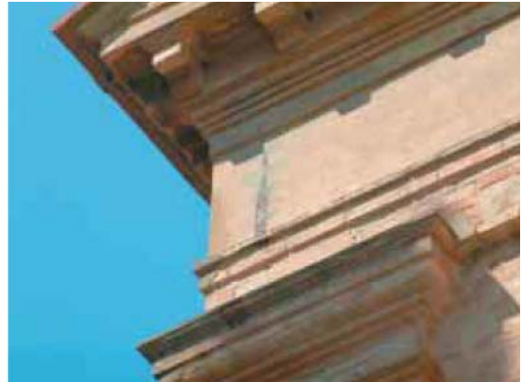
Figura 9: Intervento n°5: fissaggio dello spigolo superiore della facciata principale allo scopo di ridurre la vulnerabilità nei confronti del ribaltamento attorno al piede.
