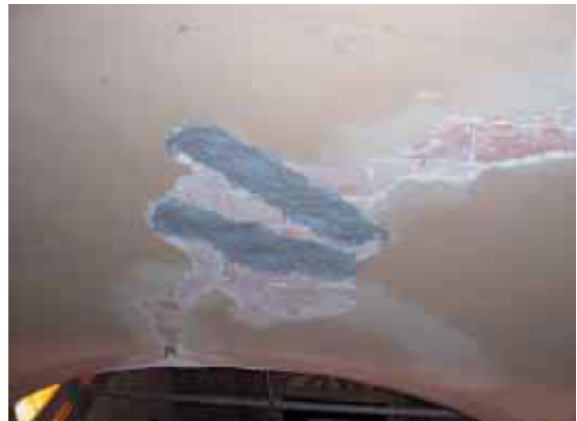
Figura 10: Intervento n°6: cucitura dei lembi delle fessure mediante scuci e cucì dei mattoni rotti e armatura con strisce di FRP ortogonale alla lesione.
