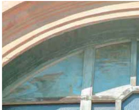
Figura 7: Intervento n°2: rinforzo del bordo delle aperture mediante barre di C-FRP inserite nei corsi sottostanti la finestra e mediante tessuto nello stipite curvo superiore.
