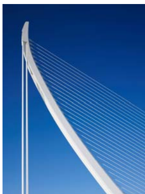
Fig. 8 Puente de Serrera
