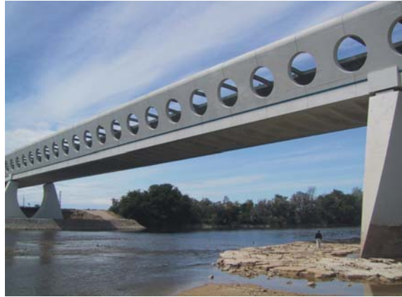
Puente sobre el río Ebro-LAV Madrid Barcelona
