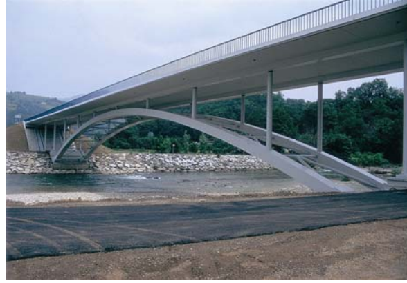
Fig. 15 Puente de Arriondas
