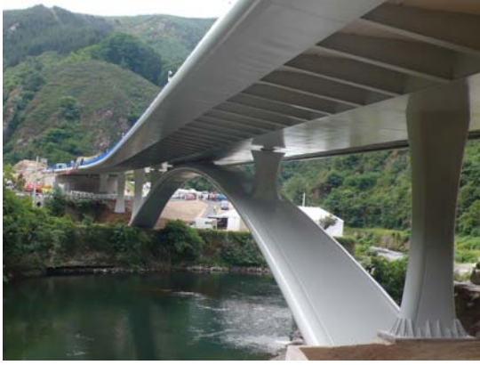
Fig. 14 Puente de Endarlatsa
