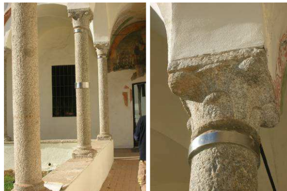
Figura 35 e 36: cerchiature delle colonne del chiostro dell'ex Monastero di San Michele a Lonate Pozzolo.
