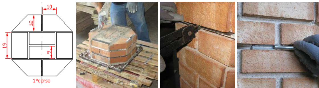
Figura 49, 50, 51 e 52: pianta e fasi esecutive di realizzazione dei pilastri in muratura.
