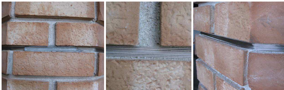
Figura 46, 47 e 48: cerchiatura con fili in acciaio inseriti all'interno dei giunti di malta dei pilastri in muratura sperimentati .
