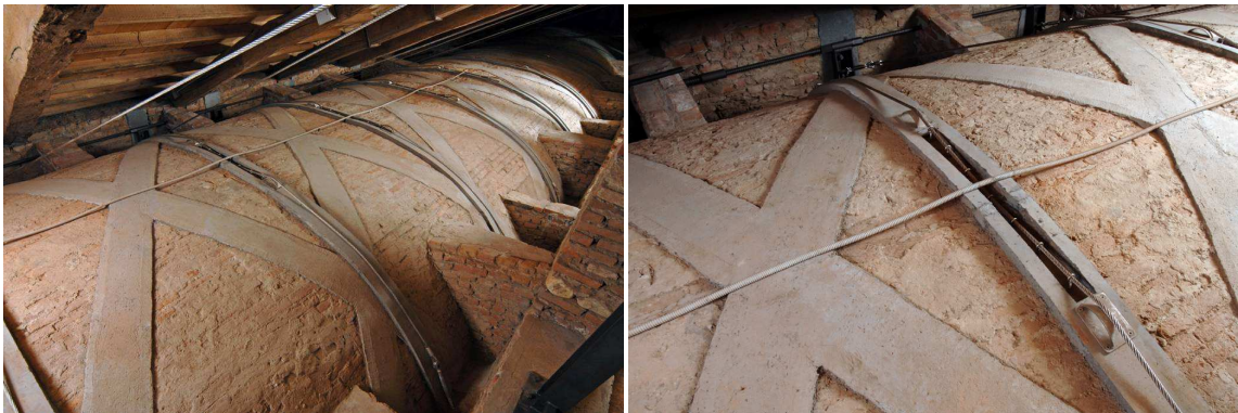
EFigure 29 e 30 – Consolidamento di una volta del castello di Masino mediante la tecnica dell'arco armato e l'applicazione di FRP, su una volta "depressa"
