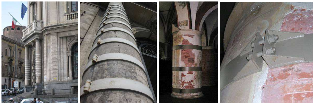
Figure 31, 32, 33 e 34: immagini di cerchiature con fasce in acciaio delle colonne d'ingresso della Camera di Commercio di Catania e delle colonne affrescate interne dell'abbazia di Chiaravalle a Milano.
