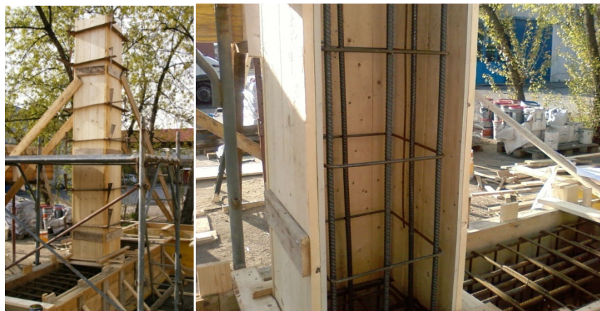
Figura 15: Realizzazione del provino.
