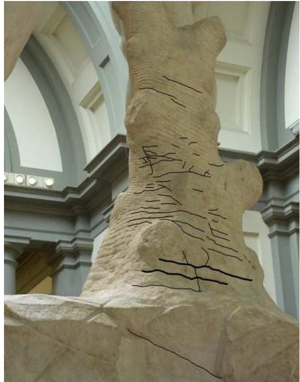
Figura 8: rilievo dello stato fessurativo nella parte inferiore del broncone
