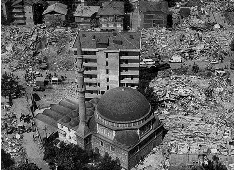
Figura 6. Danni verificatisi a causa del terremoto di Kocaeli in Turchia del 1999.
