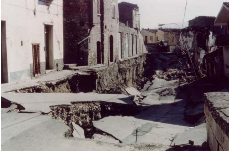
Figura 12. Frana di Calitri verificatasi in terreno argilloso a seguito del terremoto dell'Irpinia del 1980.
