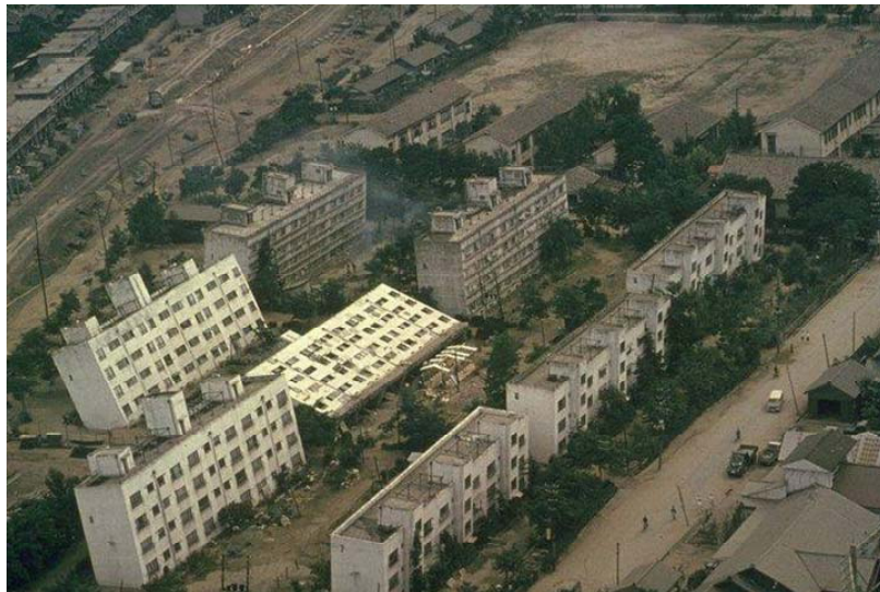
Figura 14. Sprofondamento e ribaltamento di alcuni edifici a seguito della liquefazione del terreno durante il terremoto di Niigata del 1964.
