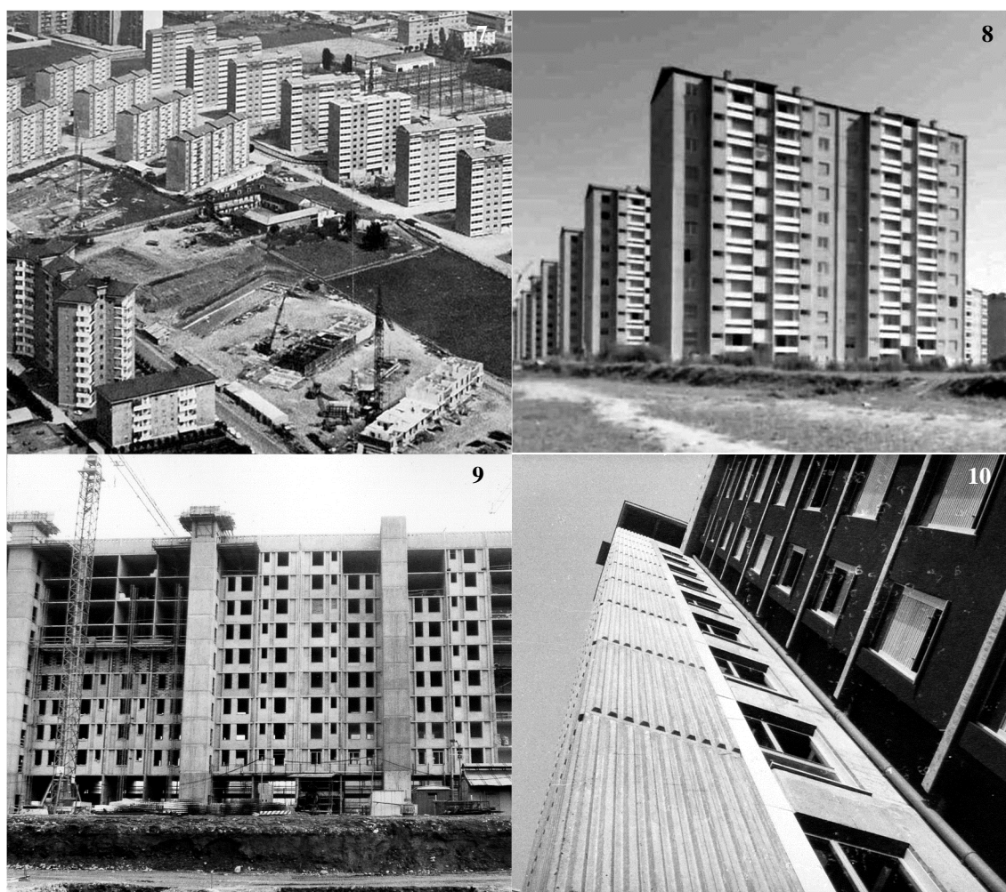
Figura 1: Sistema Barets: fase di montaggio degli elementi portanti trasversali presso il quartiere Mirafiori Sud. Figura 2: Quartiere Mirafiori Sud. Veduta panoramica del complesso. Figura 3: Sistema Co.Im.Pre.- Skarne: cantiere degli edifici a torre del Quartiere Falchera Nuova. Figura 4: Quartiere Falchera Nuova. Vista delle torri dai laghetti di Falchera. Figura 5: Sistema Tracoba: getto in opera di un pannello di facciata. Figura 6: Quartiere M 22 via Artom. Edificio di via Fratelli Garrone 73, demolito nel 2003.
