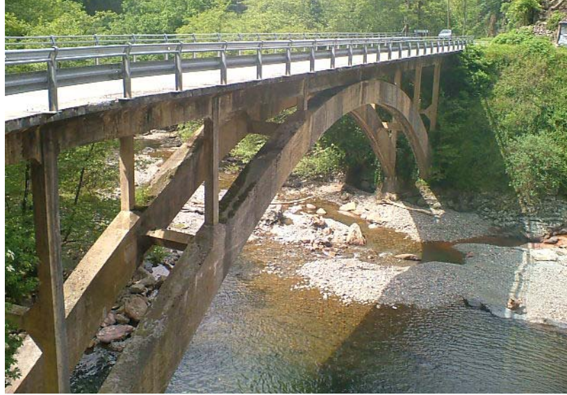
Fig. 9. Vista general del puente objeto de comprobación.
