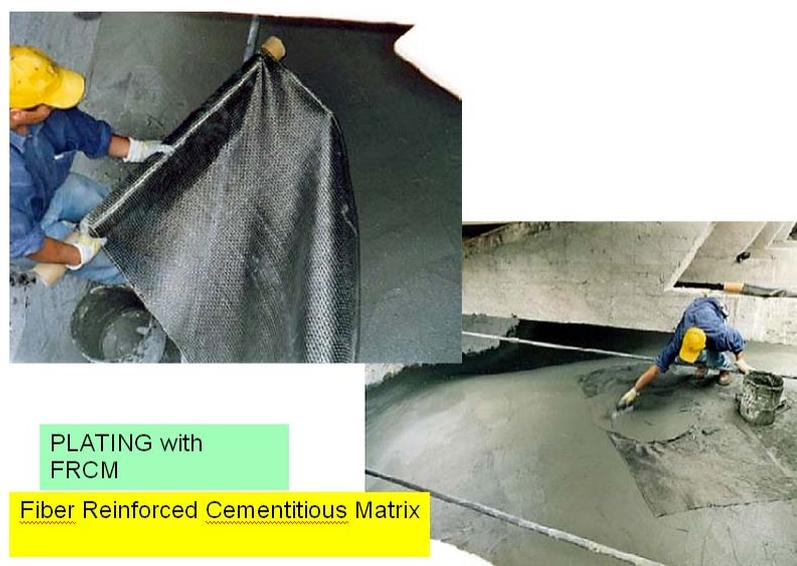
FIG. 17 - Placcaggio estradosale di volte con compositi a matrice cementizia e armatura di rete di carbonio
