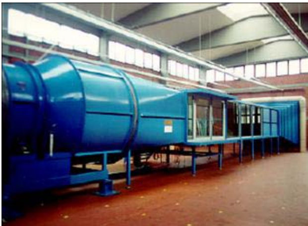
Figura 5: Vista d'insieme della galleria del vento
