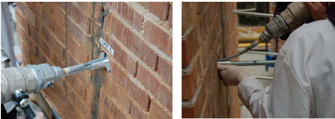
Figura 7: Fase di iniezione dell'ancoraggio.
