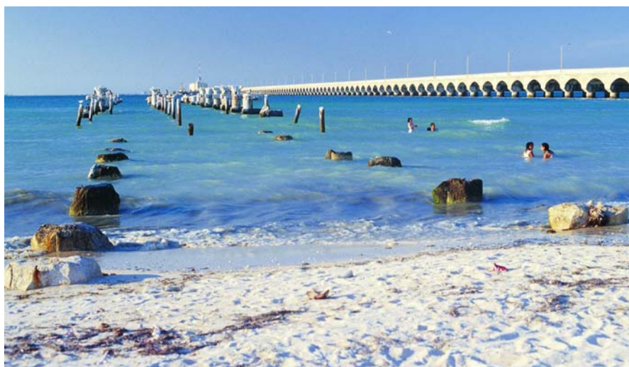
Fig. 4. La foto riporta sullo sfondo il pontile Progreso realizzato alla fine degli anni trenta con armature in acciaio inossidabile austenitico con 18% cromo e 8% nichel e, in primo piano, quello che rimane di un pontile con armature di acciaio al carbonio costruito agli inizi degli anni sessanta.
