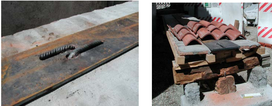
Figura 8. Prove di carico. a) Saldatura dei diagonali di diametro 20 mm alla piastra metallica posta in sommità. b) Il sistema di rinforzo secondo la configurazione finale di intervento
