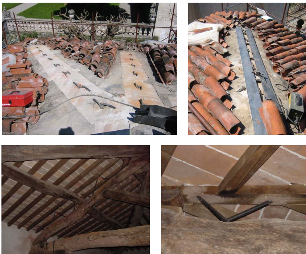
Figura 7 a, b, c, d. Dettagli di realizzazione dell' intervento in copertura
