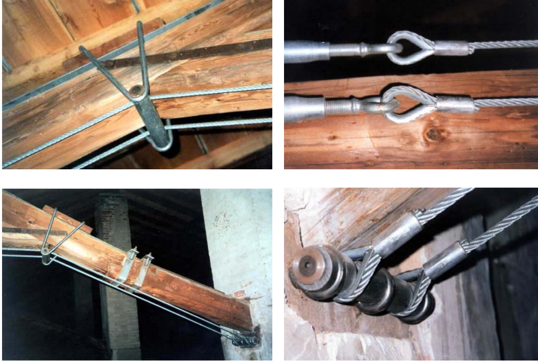
Figura 2 a, b, c, d. Dettagli dell'intervento di consolidamento con utilizzo di un cavo sagomato post tesato, in posizione intradossale, per consolidare i puntoni a sbalzo, fortemente inflessi.
