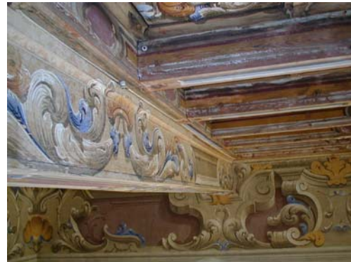
Figura 21. Vista intradossale di solaio in legno con trave primaria costituita da coppia di putrelle rivestite da fodera lignea decorata
