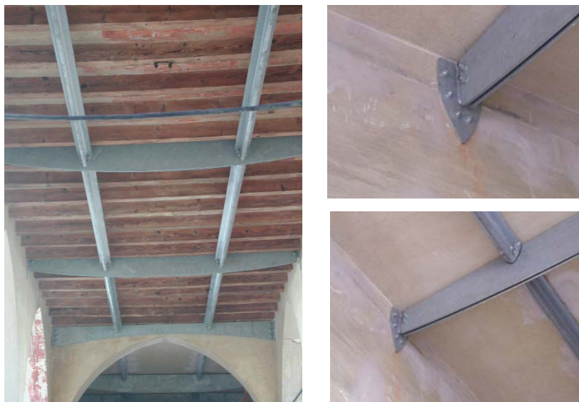
Figura 30. a, b, c. Dettagli del graticcio costituito da nuove travi metalliche.
