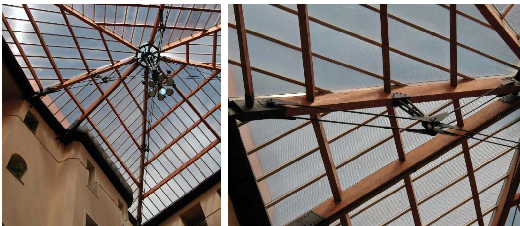
Figura 13 a, b. Copertura realizzata ad Erevan, Armenia.
