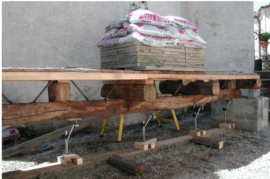
Figura 9. Prove di carico: prima fase di carico sulla parte centrale ( a P=1300 daN). A scarico ultimato non si osservano danneggiamenti.
