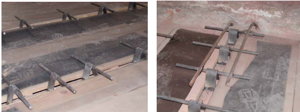
Figura 24. Immagini di cantiere.
