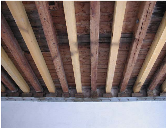
Figura 3. Vista agli appoggi del solaio, con il raddoppio delle travi lignee ed il nuovo profilo a parete.
