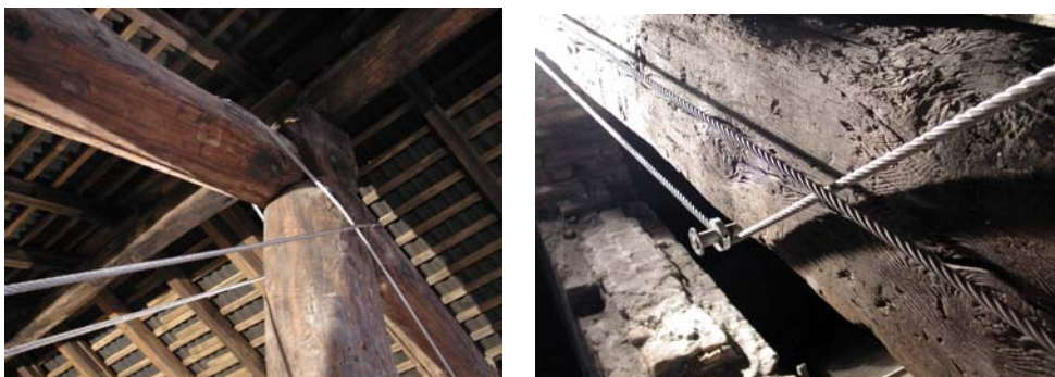
Figura 16. Dettagli di realizzazione.
