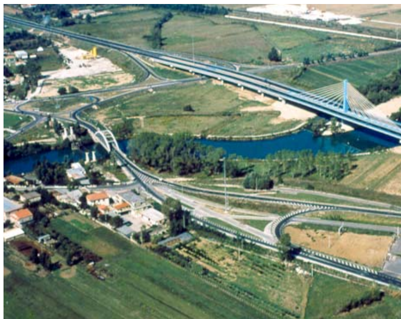
Fig. 1. I tre ponti alla foce del Garigliano. A sinistra, il ponte sospeso di Luigi Giura (1835); all'epoca della foto, l'impalcato era stato smontato e quindi sono visibili solo le antenne ed i cavi. Al centro, il ponte in c.a. di Giulio Krall (1936). A sinistra, il ponte strallato di Michele Mele (1993)
