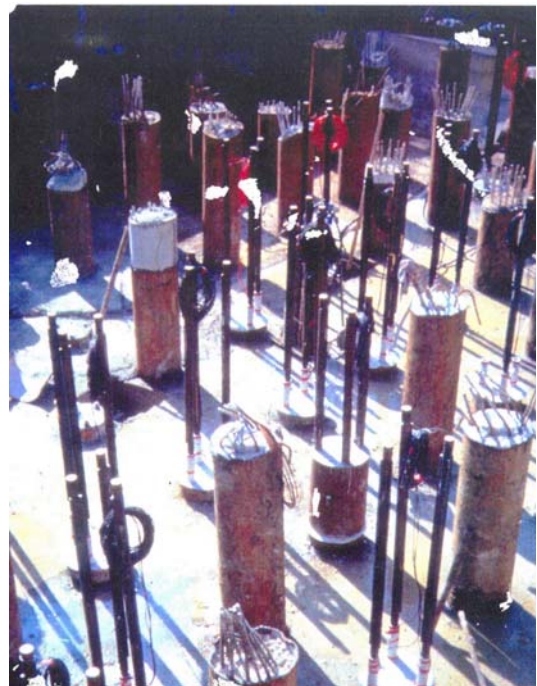
Fig. 7. ISTALLAZIONE DEI DINAMOMETRI PER LA MISURA DELLO SFORZO TRASMESSO AI PALI
