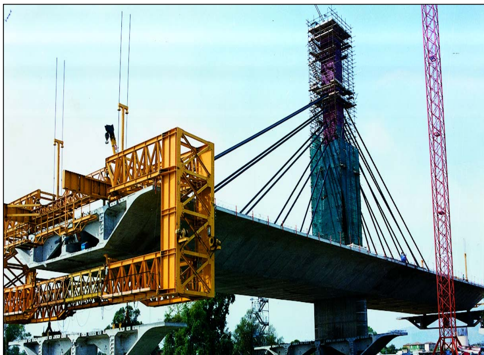
Fig. 9. La realizzazione dell'impalcato con conci a sbalzo dalla pila centrale
