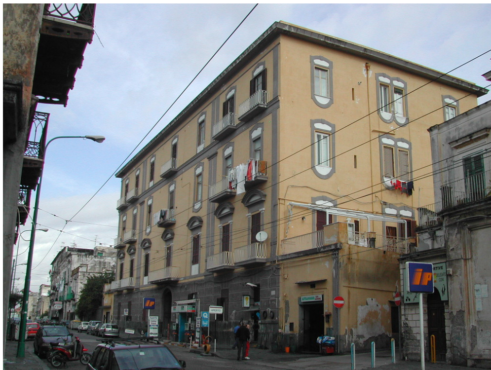
Figura 1. Edificio presso il quale si è verificato il crollo
