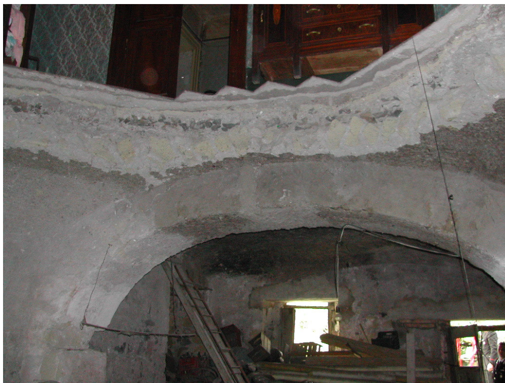
Figura 6. Particolare delle superficie di distacco
