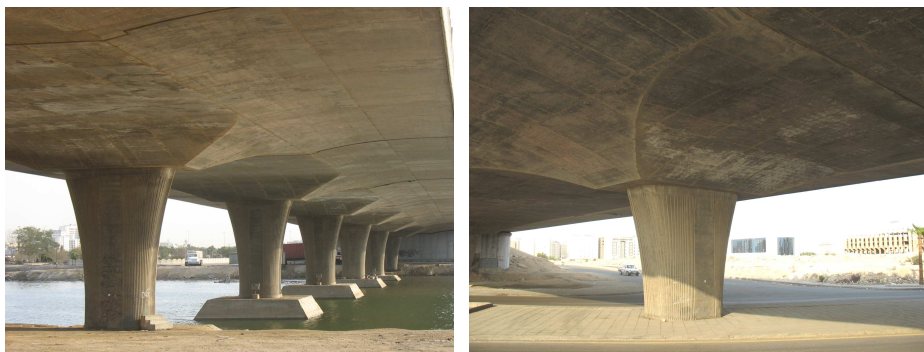
Fig. 26: Visione generale di uno dei ponti a piastra costruiti a Jeddah
