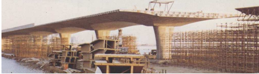
Fig. 25: Foto della costruzione del ponte a piastra sulla laguna Ruwais
