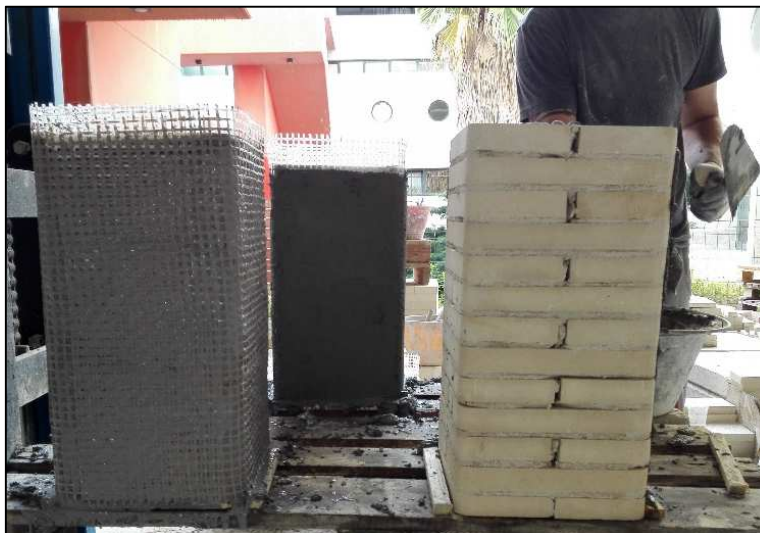
Figura 10: Esempio di confinamento con FRCM: colonna non confinata ( destra ), applicazione della rete sul primo strato di malta ( sinistra ) e realizzazione della finitura a base di malta ( centro ).
