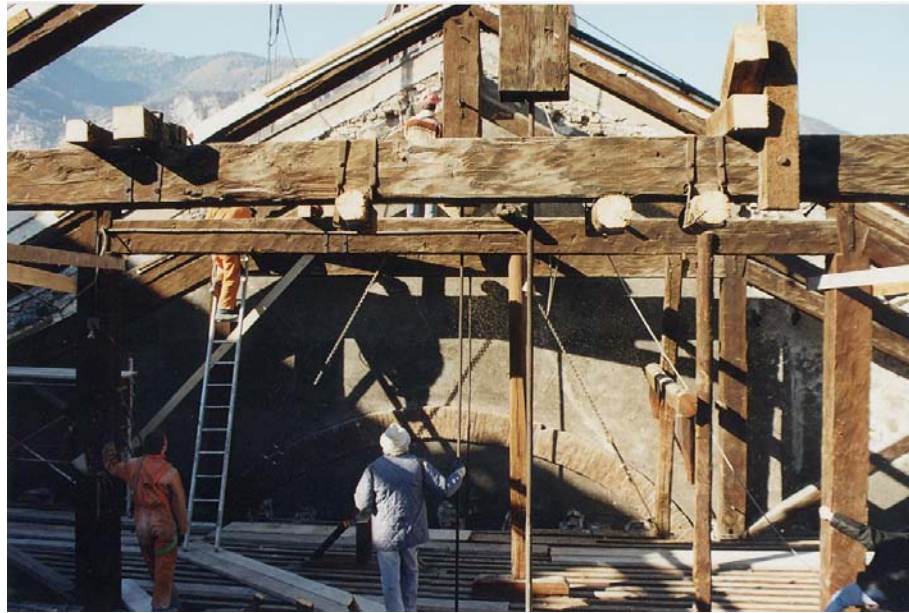
Figura 5. Smontaggio delle capriate lignee dalla copertura del Teatro Sociale di Trento
