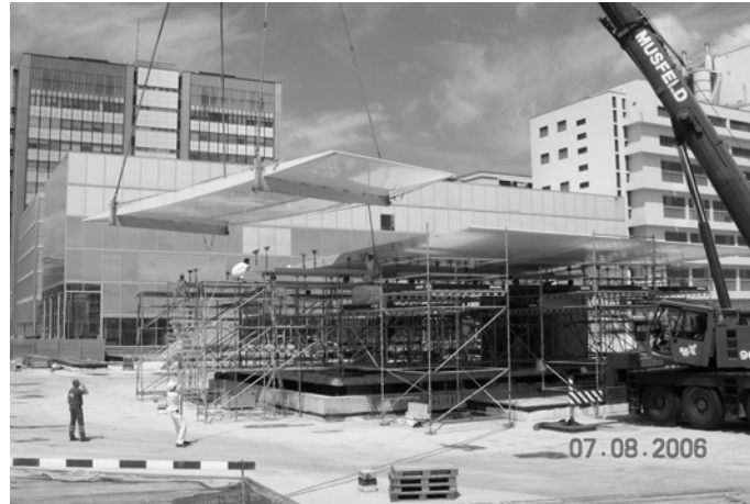
Figura 13. Edificio Novartis, assemblaggio del tetto in cantiere
