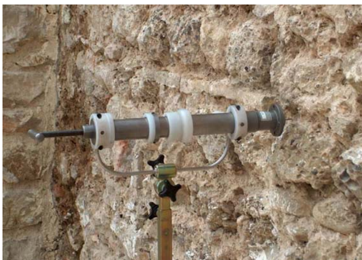
Figura 5: Foto dell'apparecchiatura durante una prova in situ.
