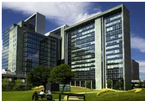
Figura 13: Colonne HH nell'edificio Herriots a Francoforte.
