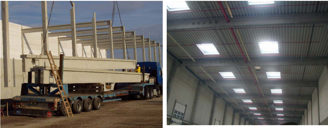
Figura 18: Centro di distribuzione durante la fase costruttiva e dopo il completamento.
