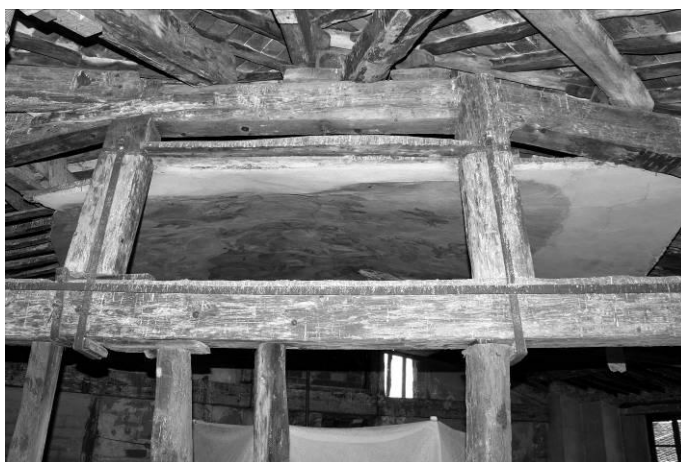
Figura 7 . Affresco della Gloria di Santa Caterina , di Lorenzo Castellotti, fissato su supporto incanniccio alla struttura lignea di copertura, prima degli interventi di restauro
