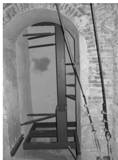
Figura 22. Scala interna al campanile, in fase di realizzazione
