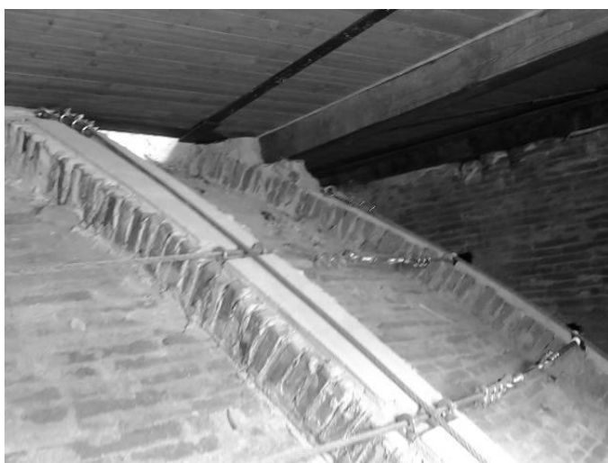
Figura 21. Intervento di rinforzo della cupola ellittica con trefoli di cerchiatura paralleli e trefoli meridiani sulle costole
