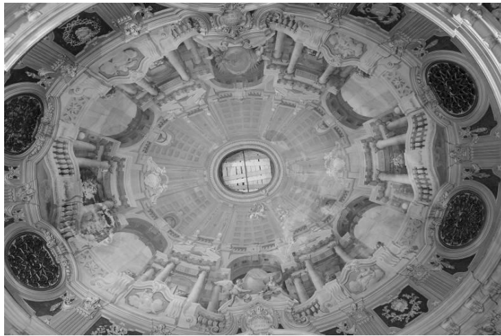
Figura 5. Gli affreschi di Bartolomeo De Santi Chiesa di Santa Caterina a Lucca prima dell'inizio del cantiere
