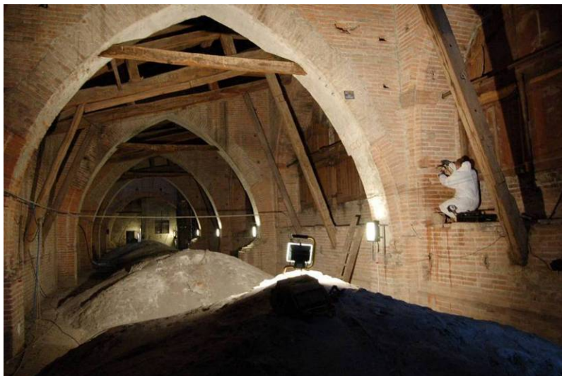
Esecuzione della prova con martinetto piatto singolo nei matronei.
