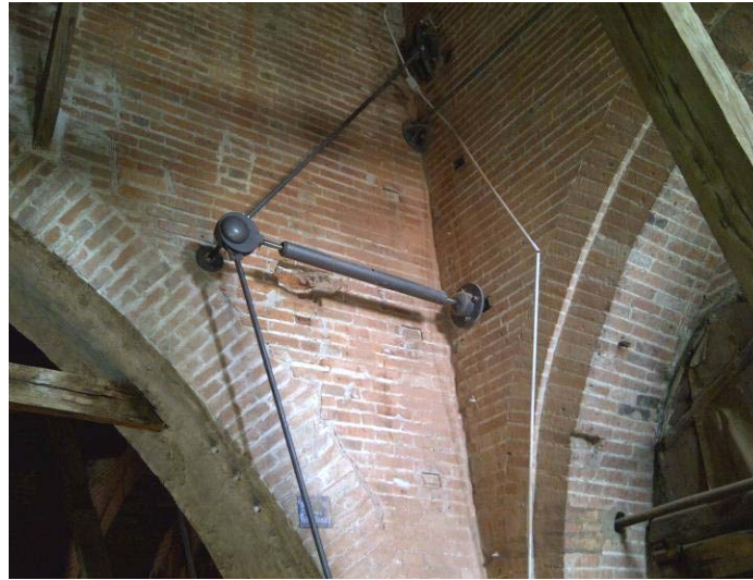
Nodo sferico a cui converge il puntone telescopico.
