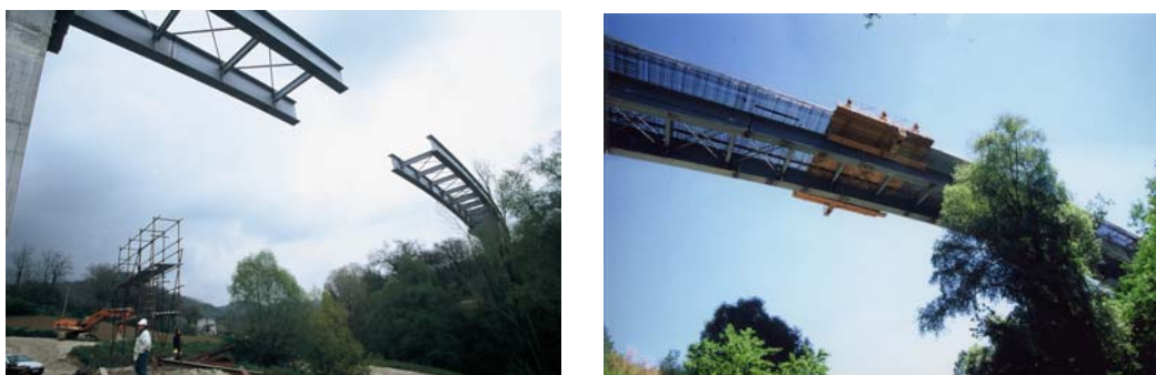
Figura 6 – Varo della carpenteria metallica e getto della soletta
