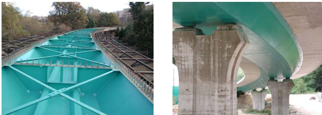
Figura 13 – Viadotto Fontescodella - Macerata
