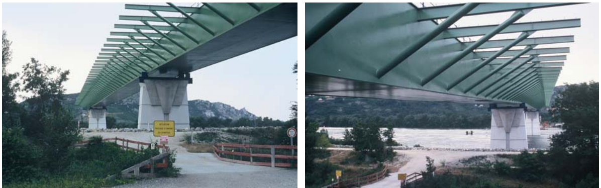
Figura 16 – Nuovo ponte sul Rhône a Valence - Francia
