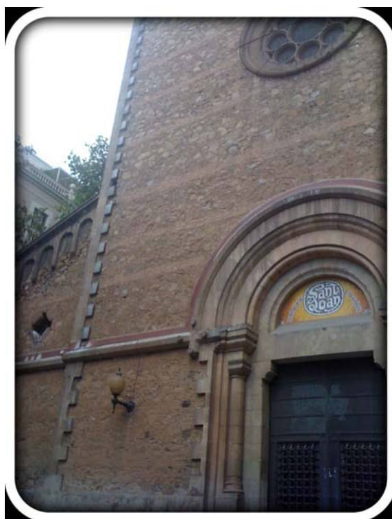
FIG. 16 – Muratura “listata” nella facciata di Saint Joan a Barcellona (Spagna)
