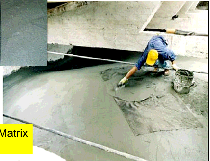
FIG. 18 - Placcaggio estradossale di volte con compositi a matrice cementizia e armatura di rete di carbonio
