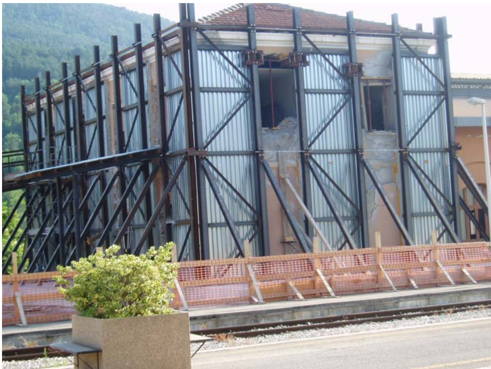
FIG. 10 Sistema a gabbia metallica con puntelli .
