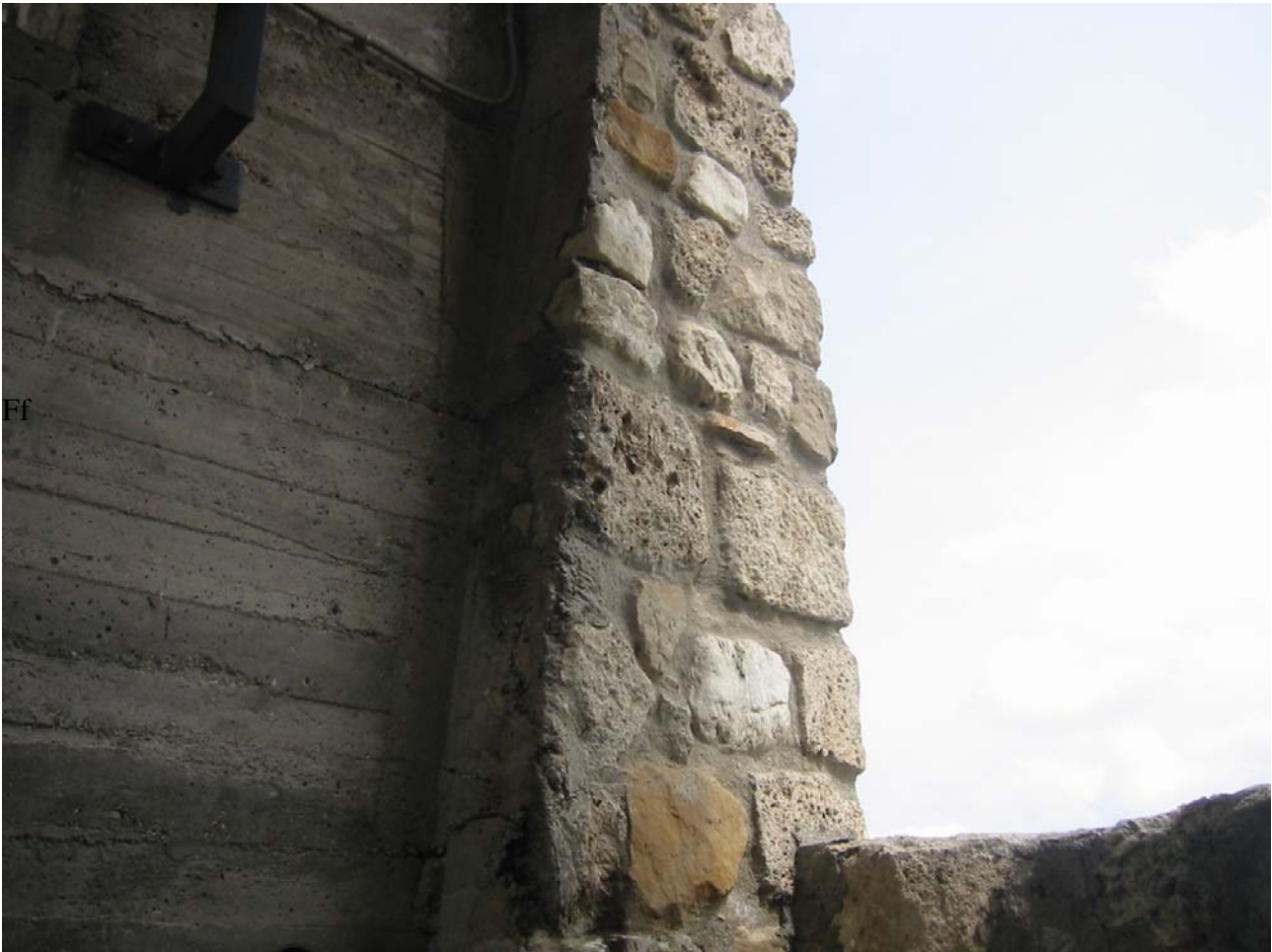
FIG. 13 - Intervento “pesante” di rifacimento in calcestruzzo armato e falsa muratura Campanile di S. Francesco a Campli (TE)
