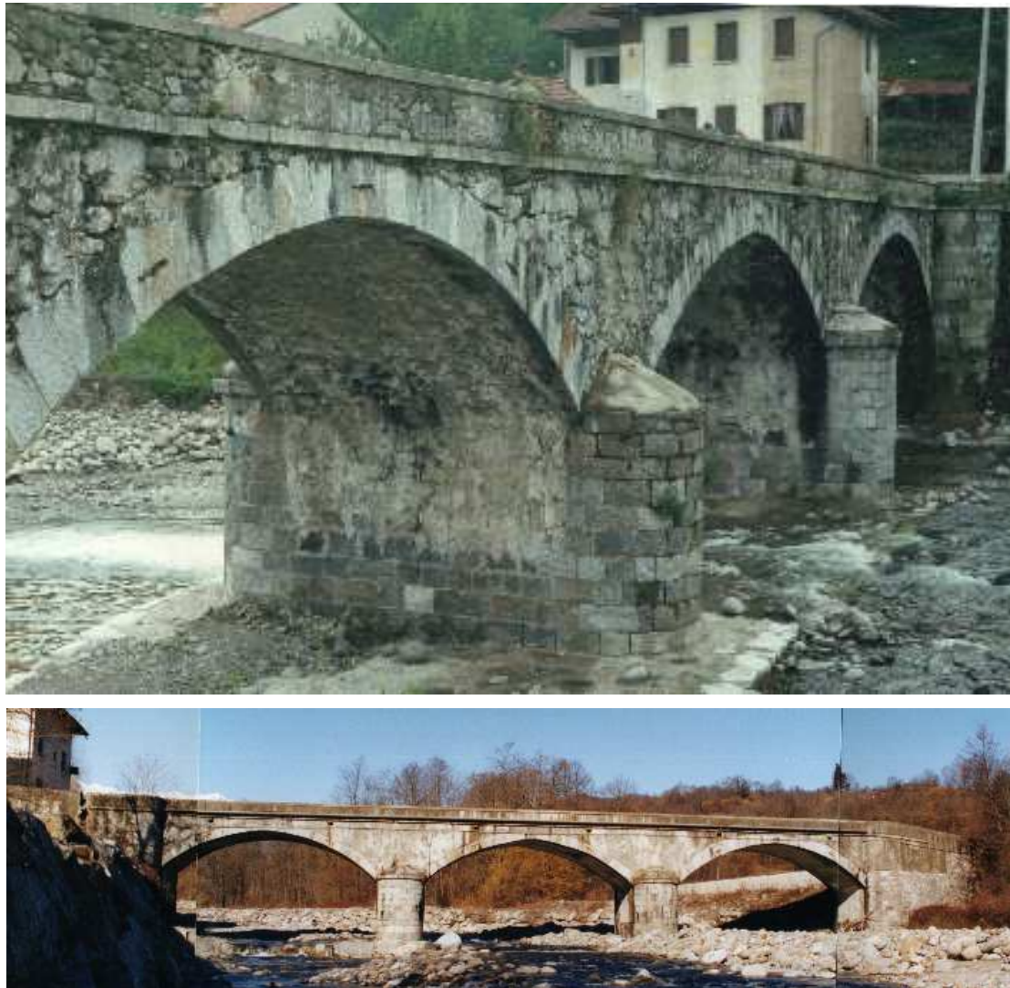
Figura 23. Viste del ponte
