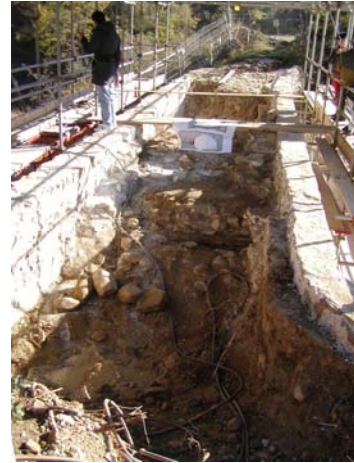
Figura 36. Immagini di cantiere: situazione riscontrata al termine della fase di rimozione dei rin fianchi.
