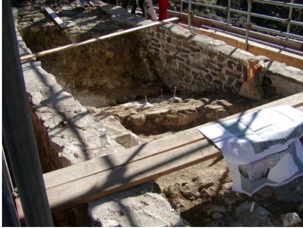
Figura 36. Immagini di cantiere: situazione riscontrata al termine della fase di rimozione dei rin fianchi.
