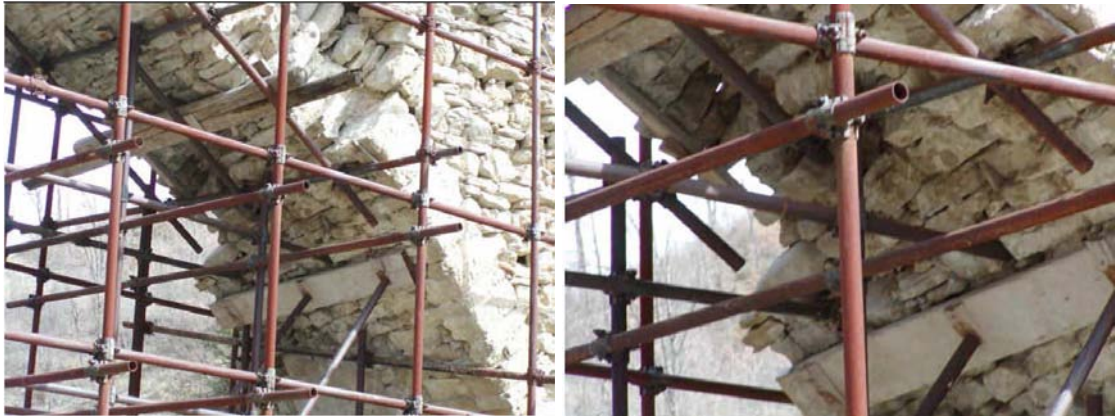
Figura 33. Situazione precedente l'intervento di presidio.
