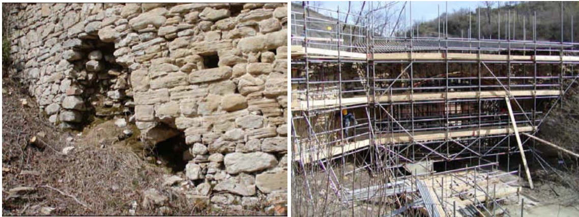
Figura 34. Situazione precedente l'intervento di presidio e struttura provvisoria di presidio in fase di allestimento
