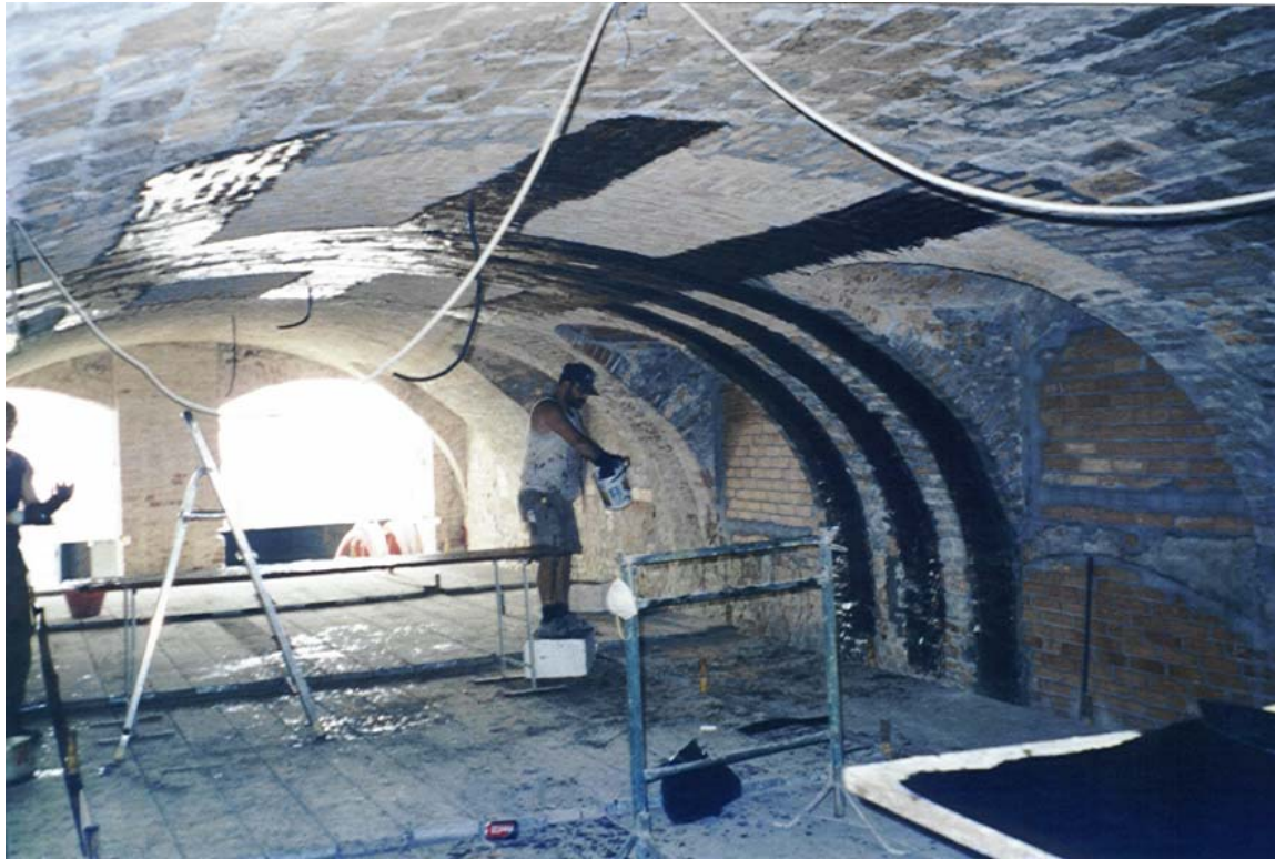
Figura 23.a: Applicazione di rinforzi in composito all'intradosso di una volta a botte con lunette. Il quantitativo di rinforzo è notevole (elevato rapporto tra pieni e vuoti) poiché il sovraccarico della volta è costituito da una piscina.
