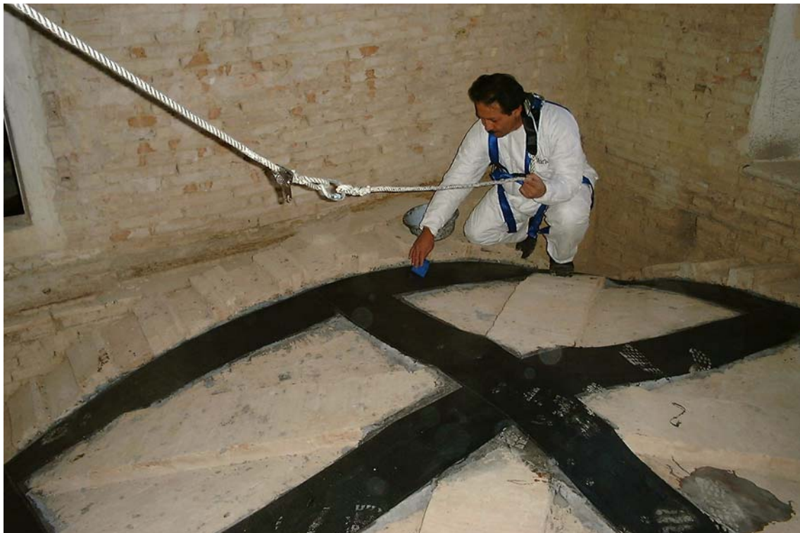
Figura 23.b: Applicazione di rinforzi in composito all'estradosso di una volta a crociera nervata. La volta è destinata ad un uso piuttosto oneroso.
