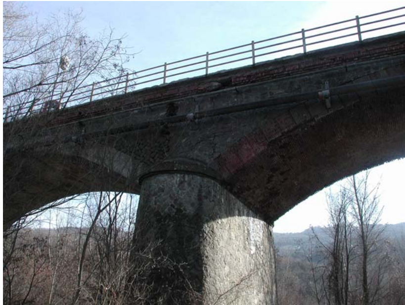
Figura 36: Ponte Locatelo, sito a Rioveggio (provincia di Bologna). Trattasi di ponte a quattro arcate ribassate, di cui due in muratura e due in cls.
