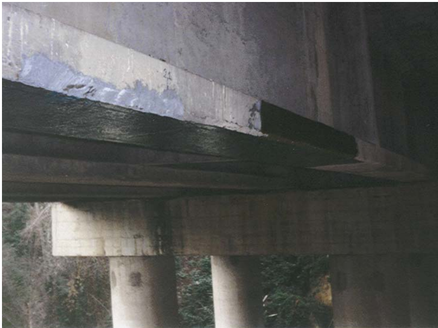
Figura 13.6: Immagine fotografica dell'intervento di Figg. 13.4-5, finito.
