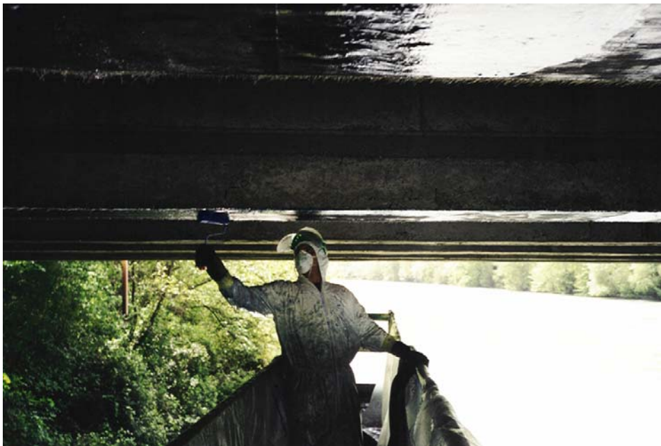
Figura 13.4: Applicazione dei nastri in composito fibro-rinforzato (carbonio e resina epossidica).
