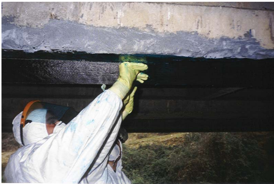
Figura 13.2: Applicazione di nastri in composito a fibra di carbonio alle travi dell'impalcato di Fig. 13-1.
