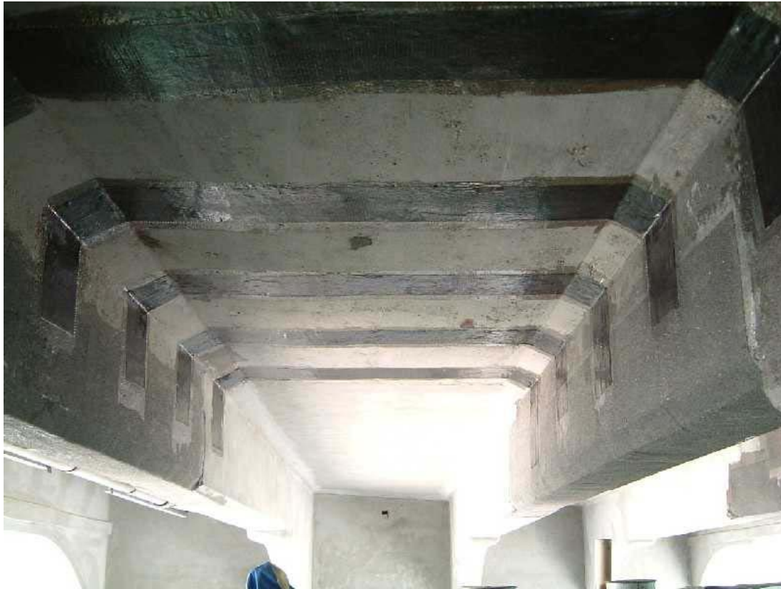
Figura 15.f: Rinforzi trasversali della III fase, atti ad incrementare la portanza flessionale trasversale della soletta. Si osserva il risvolto sui rinforzi della I fase.
