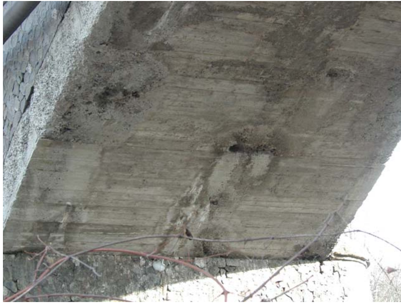
Figura 39: vista di uno degli archi in cls di Ponte Locatello.
