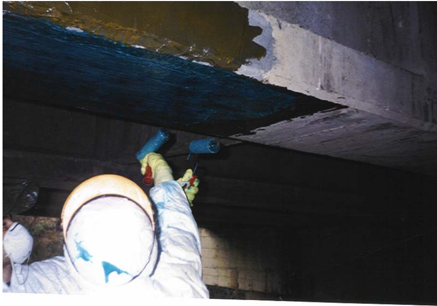
Figura 13.5: Operazione di rullatura di rinforzi intradossali all'impalcato di un ponte. Dopo la rasatura del contorno di cls, avviene l'applicazione dei tessuti (fibra nuda di carbonio tessuta mediante termo-saldatura). La successiva impregnazione del tessuto con la resina (rullatura) origina contemporaneamente il composito ed il suo incollaggio alla struttura.
