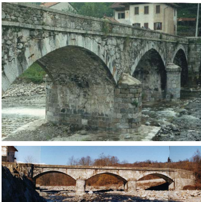
Viste del ponte
