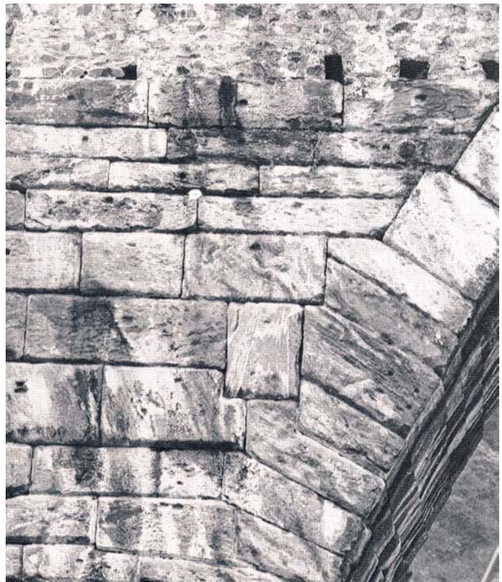
Ponte di Pont-Saint-Martin in Valle d'Aosta, nella porzione inferiore delle spalle i conci e i cunei sono in opera quadrata e le loro facce a vista mostrano un bugnato a superficie piana e ruvida con spigoli smussati.
