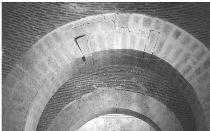
Fig.13 – Sistema ad arco: a) scivolamento di un blocco di conci, b) rottura parziale di un concio.
