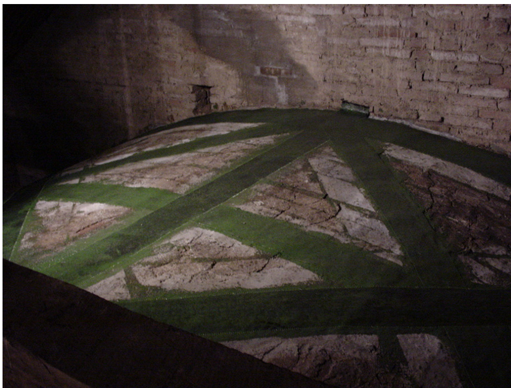
Figura 13-b. L'analisi ha verificato l'inadeguatezza statica e sismica delle volte. L'inadeguatezza era morfologica e quindi riguardava ciascuna volta. La fessurazione, oltre che ininfluente, era incidentale e riguardava una sola volta. L'intervento è consistito nel rinforzo estradossale in composito di tutte le volte.
