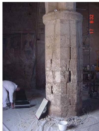
Figura 10-a. Le colonne della chiesa avevano una sezione inadeguata a portare i pesi propri in sicurezza; per di più le colonne erano dissestate. Il confinamento delle colonne avrebbe richiesto una cinturazione applicata su quasi tutta la loro superficie esterna, la quale sarebbe stata inaccettabile sul piano restaurativo.
