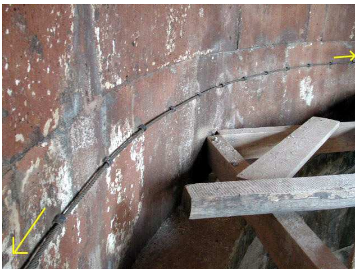
Figura 32 Cerchiatura interna di contenimento della cupola del Santuario di Tresivio (SO)
