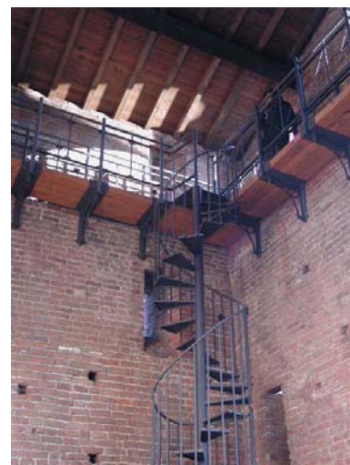
Figura 13 La trave-passerella, a vincolo delle pareti verticali, realizzata a Porta Nuova, Pavia
