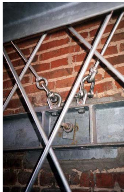
Figura 2 Confinamento della muratura tramite tiranti inseriti nelle buche pontae: schema e vista dall'esterno della piastra inox di ancoraggio. Figura 3 La “torre nella torre” vista dall'interno, particolare dei pendini e degli anelli perimetrali.
