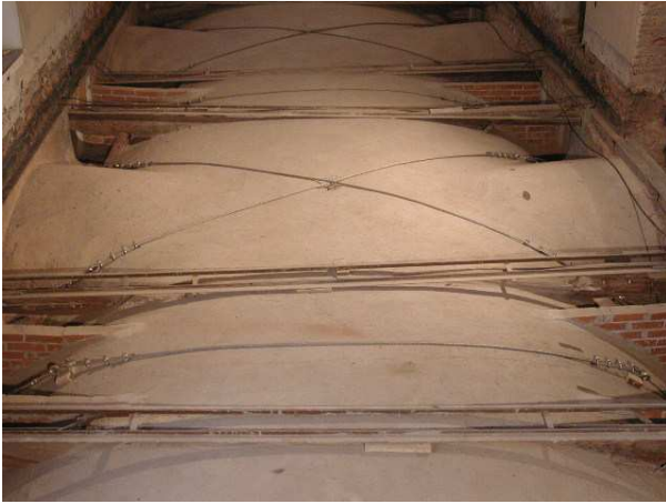
Figure 22 e 23 Intervento con “arco armato” a Casa Giacobbe, Magenta: volte consolidate con cavi messi in trazione mediante tenditori di estremità
