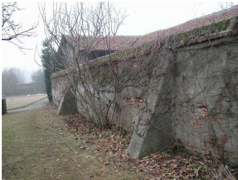
Figura 8 Contrafforte in muratura a contrasto delle spinte esercitate da una cupola spingente, Oratorio di S.Biagio a Rosate (MI)
