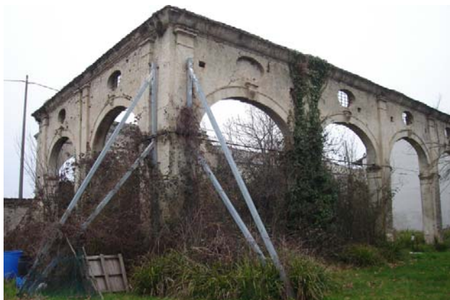
Figura 4.2. Immagine del lato villa
