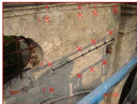
Figura 4.19. dettaglio dell'indagine sonica condotta sugli archi
