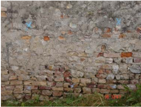
Figura 4.6. Brano della muratura prospetto Nord
