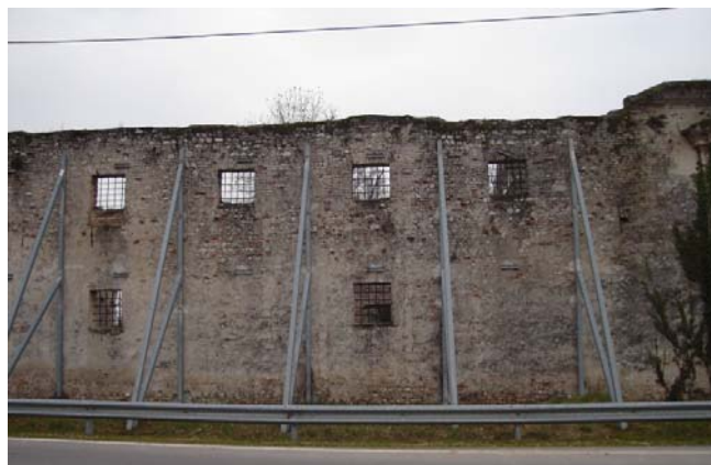
Figura 4.3. Particolare del prospetto Nord
