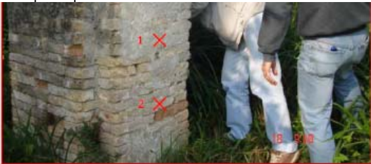
Figura 4.23. griglia ortogonale di battute e di ricezione di un pilastro per le prove soniche dirette
