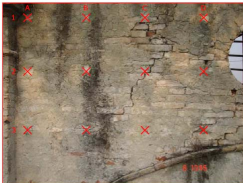
Figura 4.16. dettaglio dell'indagine sonica condotta sugli archi
