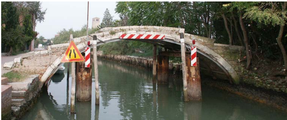
Figura 2.1 Foto del ponte del Diavolo sull'isola di Torcello
